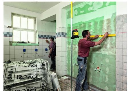
Feine, gut sichtbare Kreuzlinien vereinfachen das exakte Ausrichten und Verlegen von Fliesen. Das Fugenbild von Wandfliesen kann so präzise angepasst werden. Mit der optional erhältlichen Laser-Teleskopstange LT 30 lässt sich der LAX 400 leicht auf die gewünschte Arbeitshöhe positionieren.
